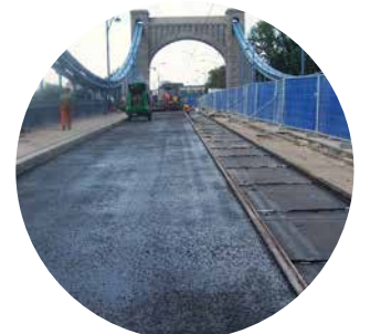
Prace z nawierzchnią można rozpocząć po 4 godzinach
